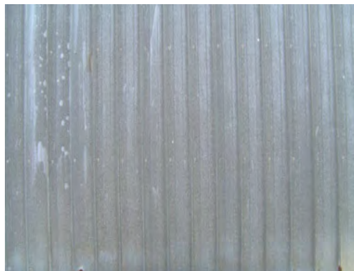
Gegalvaniseerde panele wat vir mure of dakke gebruik word.
